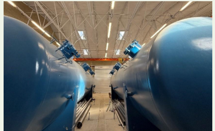
Foto: Recipientes filtrantes en la nueva planta de tratamiento de aguas subterráneas
